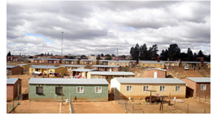
Maisons construites par le programme de reconstruction et de développement (RDP) à Soweto.
