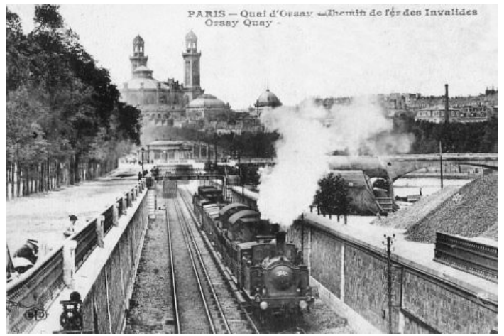
la ligne des Invalides en 1900
